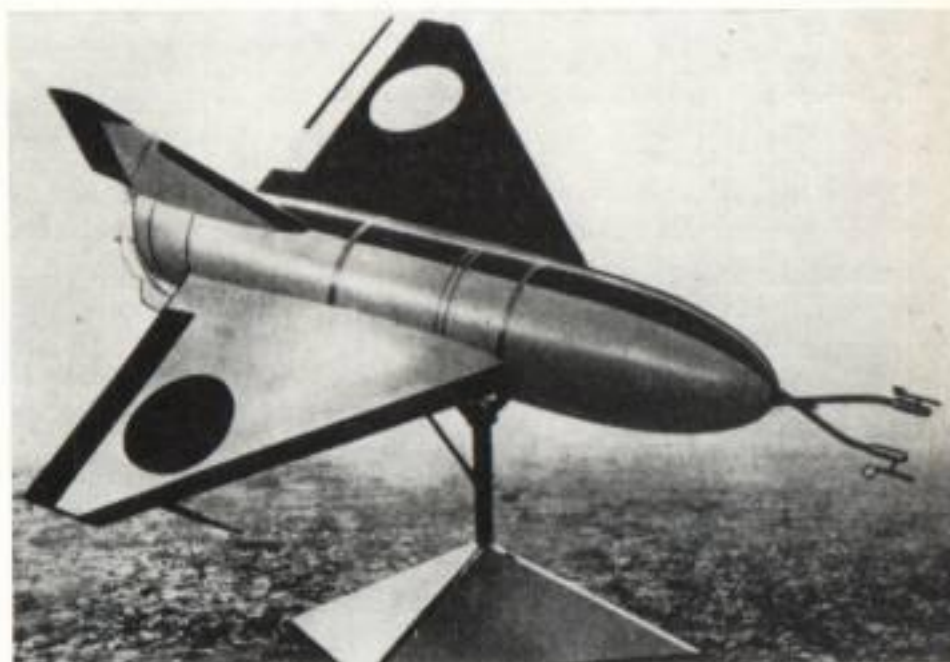
6. Modello volante in scala ridotta dell'aeroplano-razzo Fairey VTOL ad ala triangolare.
